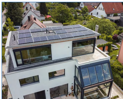
Eines der ersten Wasserstoff-Häuser steht in München.
