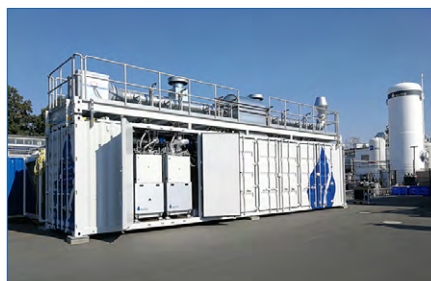
SOEC-Elektrolyseur im Stahlwerk Salzgitter; Bildrechte: Sunfire GmbH
