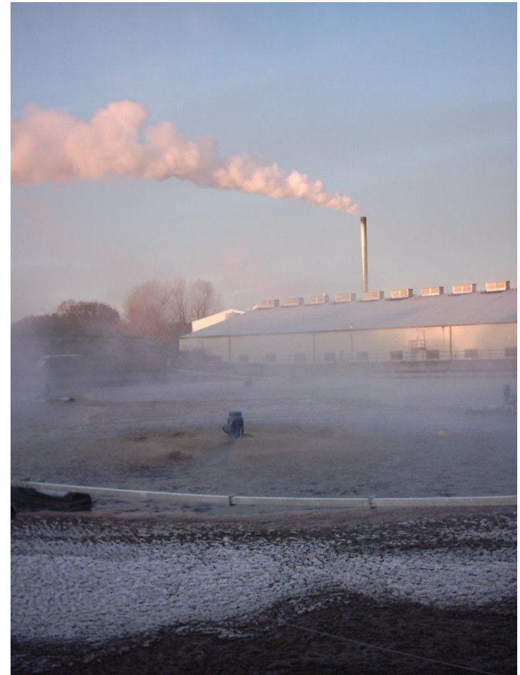
Belebungsbecken des Wasserverbands Gifhorn, © Wasserverband Gifhorn
